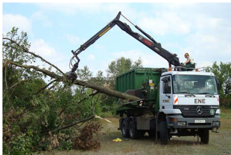
Beräumung von Stammholz mit unserem Großhacker
